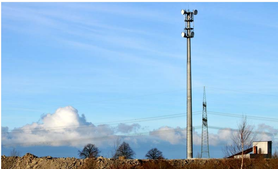
Ab 2010 soll mobiles Breitbandinternet über Rundfunkfrequenzen realisiert werden.
